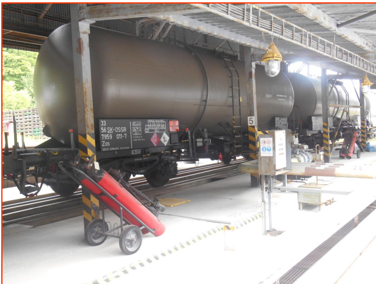
Obrázok č. 20. Priestor stáčania/plnenia železničných nádržkových vozňov v ZZ III Zemianske Kostoľany
