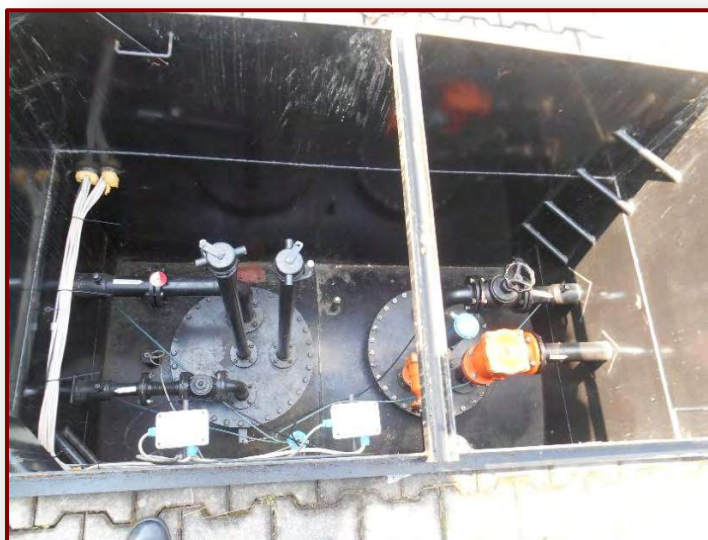
Obrázok 25. Vstupný dom podzemnej nádrže
