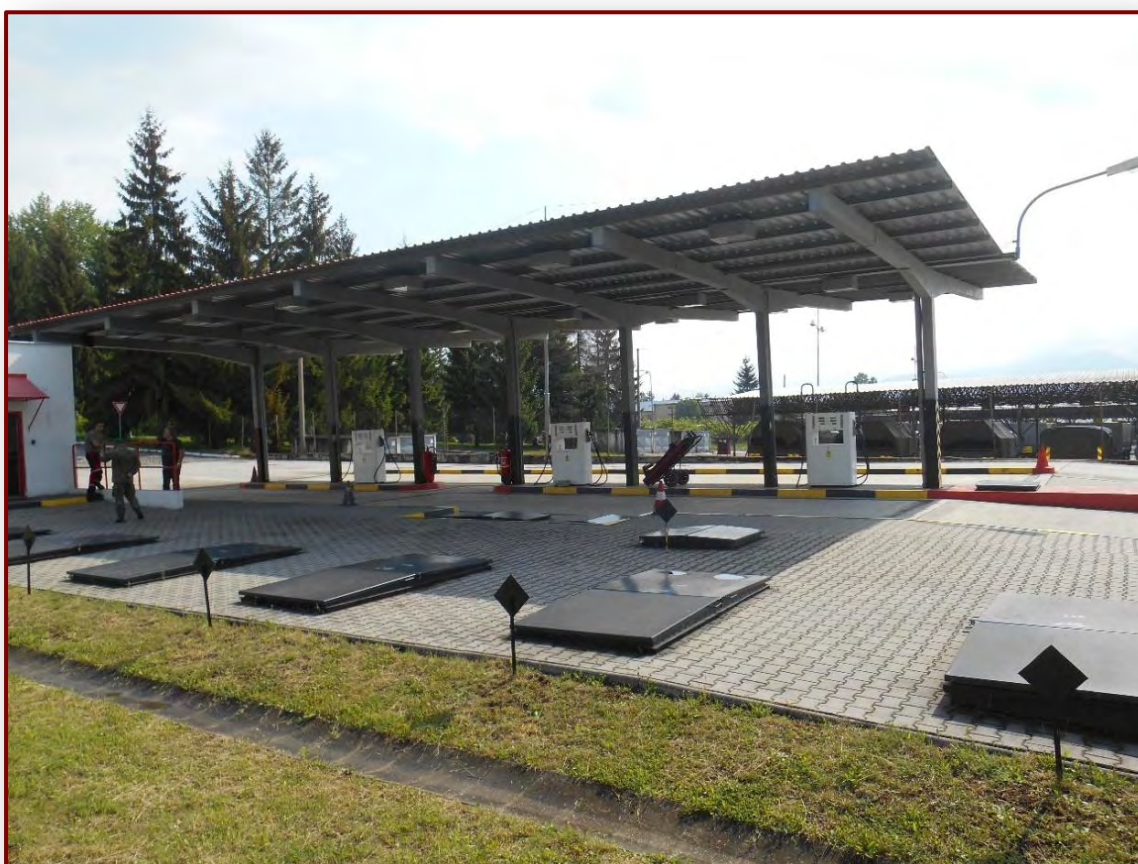
Obrázok 23. Výdajňa motorových palív vo VÚ 2730 Martin s podzemnými dvojplášťovými nádržami
