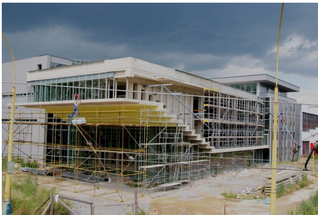
Obrázok 18: Výstavba účelovej budovy Univerzitnej knižnice TU v Košiciach (2005 – 2009)
