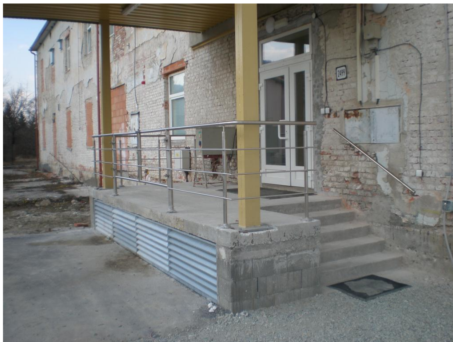
Obrázok 8: Rekonštrukcia budovy detašovaného pracoviska SNK vo Vrútkach
