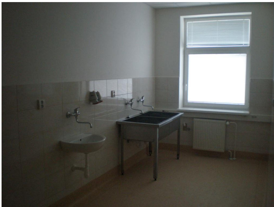
Obrázok 14: Zrekonštruované priestory detašovaného pracoviska SNK vo Vrútkach
