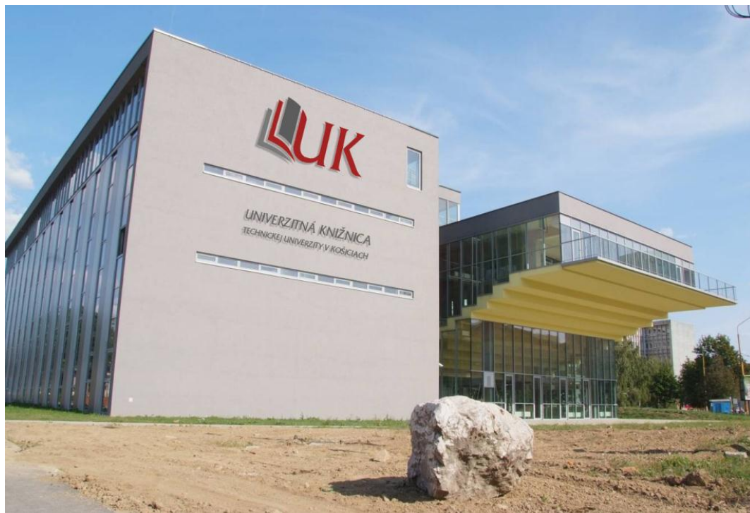
Obrázok 19: Novostavba účelovej budovy Univerzitnej knižnice TU v Košiciach po dokončení (2009)
